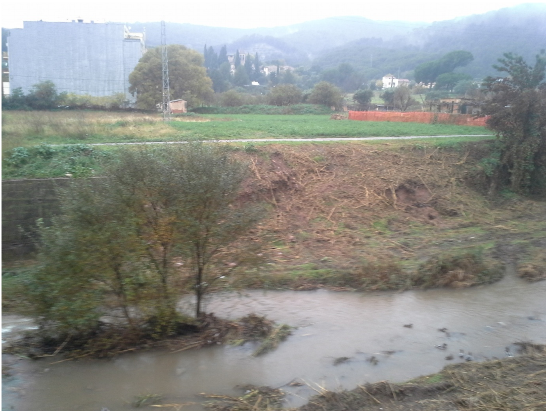
Imatge 8. Vista de la transició del mur de formigó i el talús del marge dret abans de la riuada del dia 30/11/2014 (secció G).
