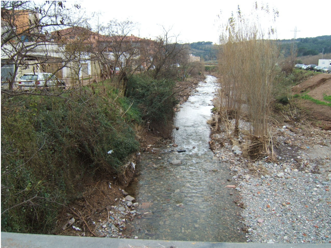
Imatge 1. Vista aigües avall del tram 1 des del pont de can Noguera.
