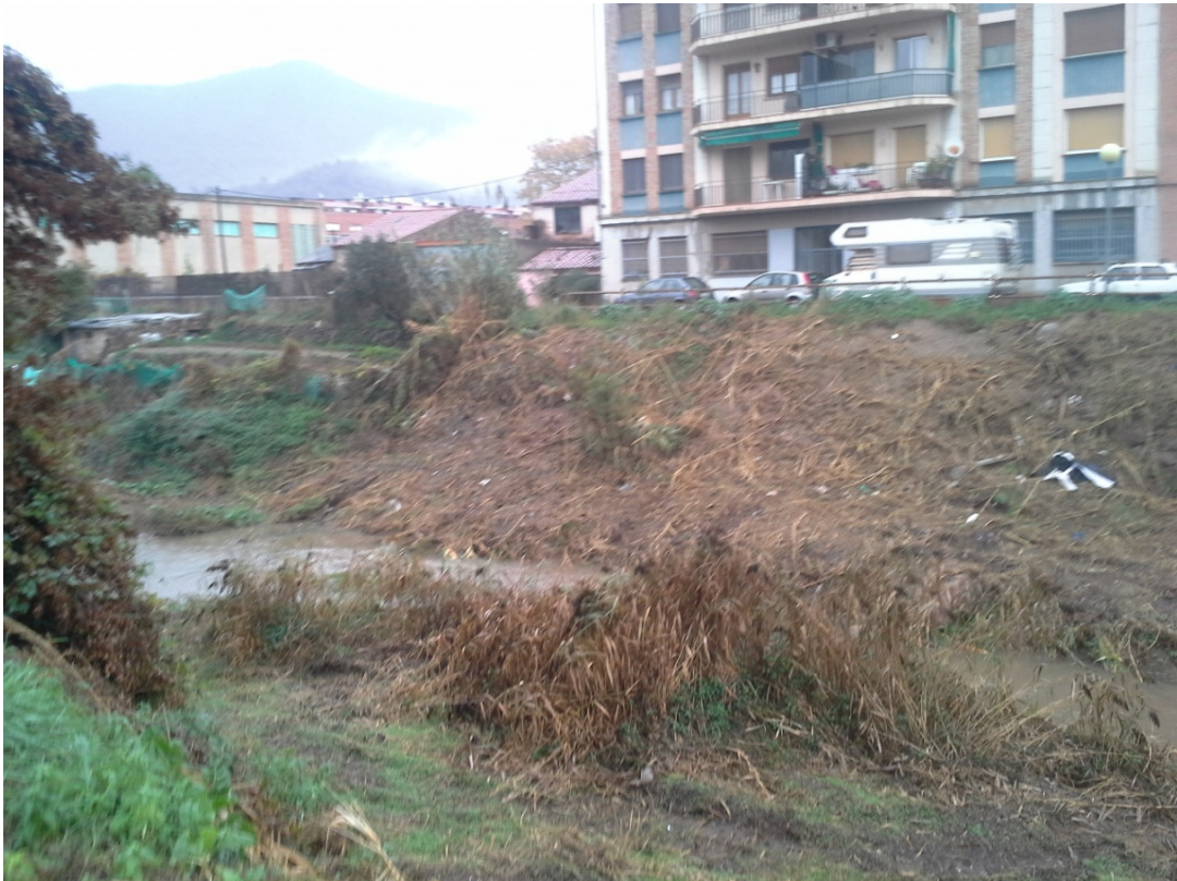
Imatge 5. Vista del talús del marge esquerre a l'inici del tram 2 (secció D).
