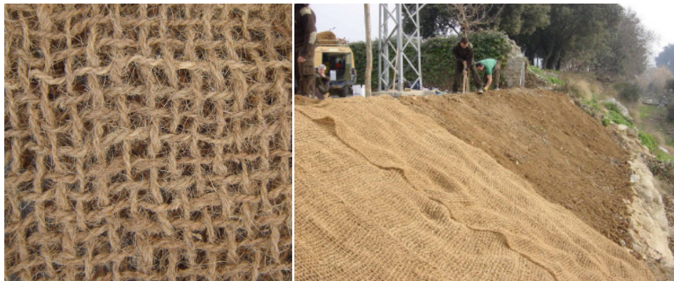
Imatge 15. Malla de fibra de coco detall i exemple d'aplicació
