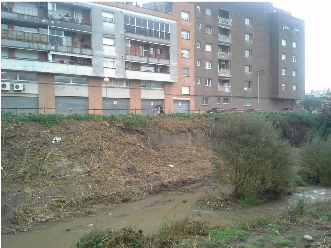
Imatge 10. Vista de la transició del mur de formigó i el talús del marge esquerre abans de la riuada del dia 30/11/2014 (secció G)
