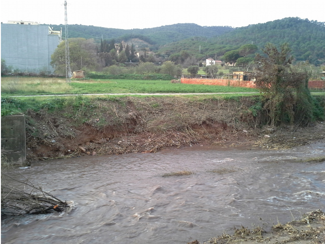
Imatge 9. Vista de la transició del mur de formigó i el talús del marge dret posterior a la riuada del dia 30/11/2014 (secció G).
