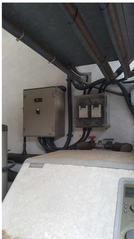
Imatge 3 : Control aeroterms, variadors de freqüència i part frontal bomba de calor NIBE Fighter 1320-40
