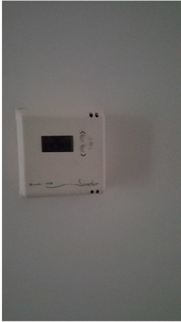
Imatge 4 : Sonda d'humitat i termòstat que hi ha per planta.
