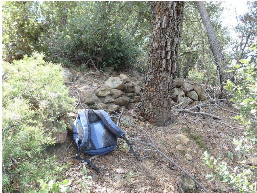
Figura 7: Detall d'un petit mur de pedra seca a prop de la cota més alta al sector de l' TCNS
