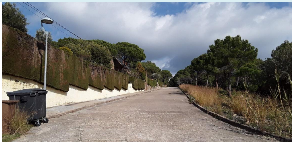
Urbanització al camí de Santa Margarida.
