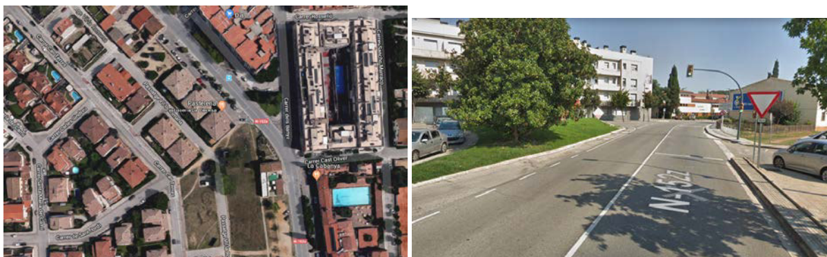
Fig. 19. Carretera Nova amb Carrer Bany. Font: Elaboració pròpia
